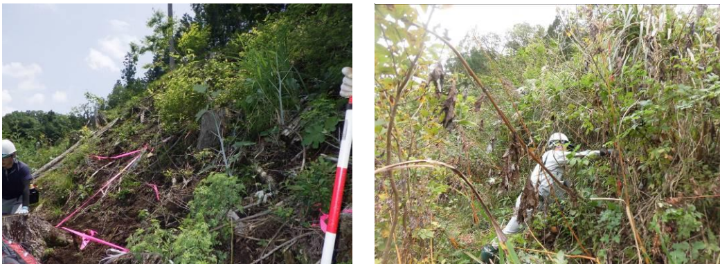
図－1 現場調査の様子
