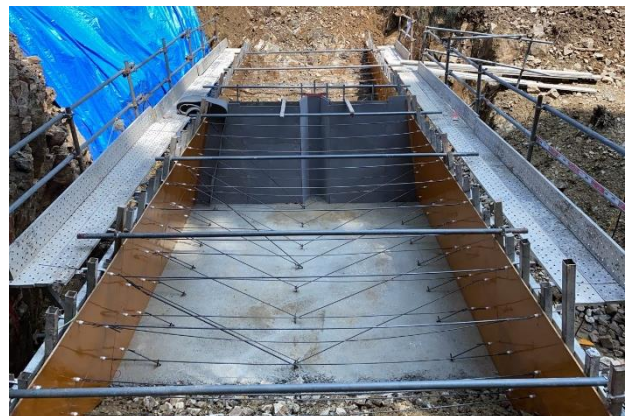
治山事業における合板型枠
