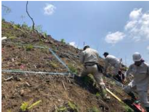
● No. 5 八幡町初音字小イ谷 ヒノキ、アカメガシワ、ネムノキ等の高木性の稚樹の実生が見られたが、全体的に植物が少ない。
