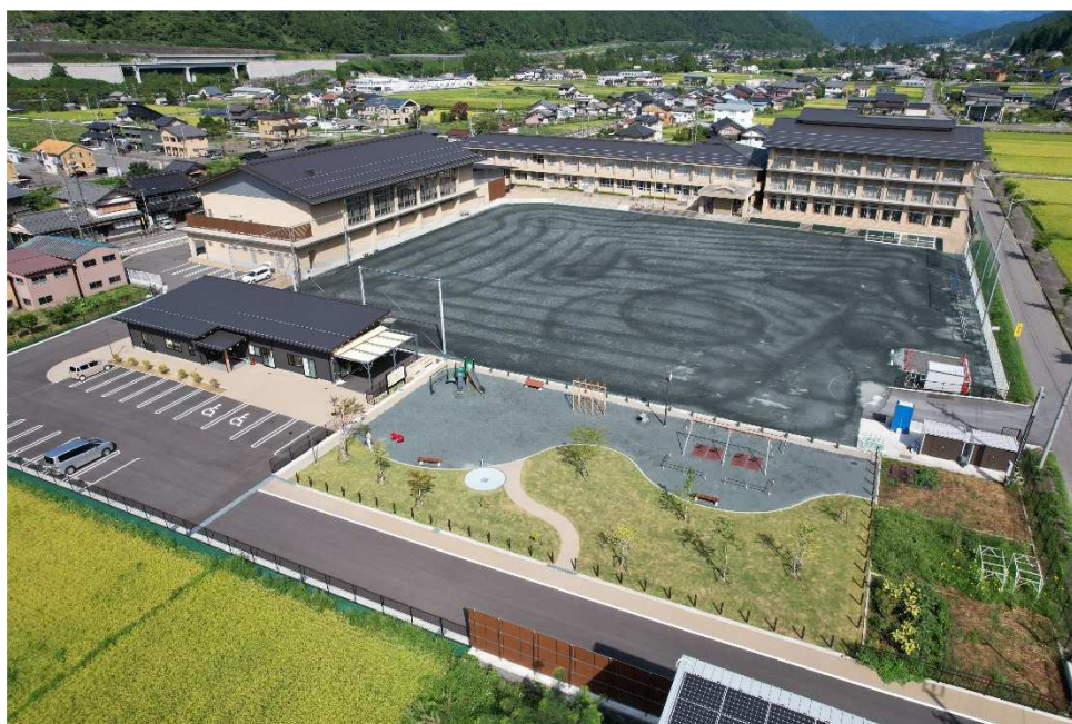
大和地域の4つの小学校を統合し、令和6年4月に開校した大和小学校
