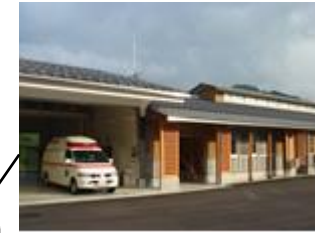
郡上中消防署東詰所
