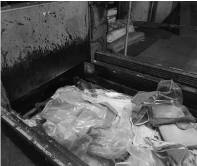
▶大型の可燃ごみは、ピットへ入れる前に裁断機で切断します。金属類が混ざっていると機械が破損します。
