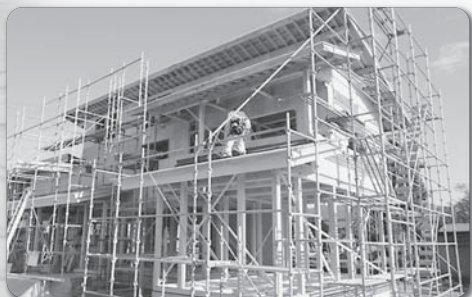
▲構造材（柱や梁等）に郡上市産材を使用
