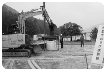
大型土のう作成訓練
