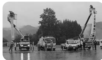
電力復旧訓練 電気設備修復訓練
