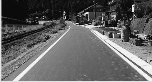
改良された市道木尾本線
