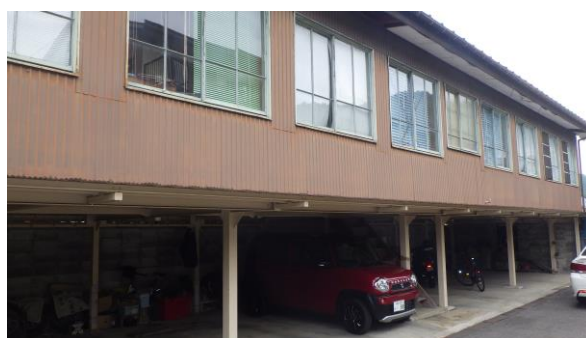
▼鉄骨棟・駐車場
