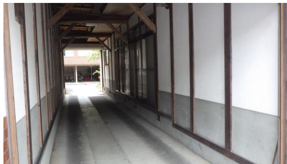
▼木造棟⇔鉄骨棟 連絡通路
