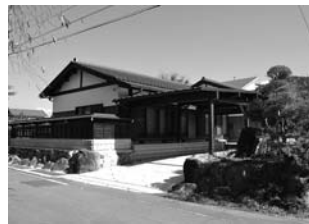
【大和町剣】 外構の塀などを含め、全体的にバランスがよく、落ち着いた外観に仕上がっています。
