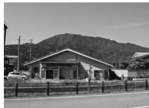
【白鳥町白鳥】 全体に木材が多く使用されており、色彩、デザイン共に調和のとれた建築物になっています。
