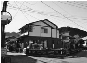
【八幡町島谷】 周辺景観に配慮された漆喰風の白壁と付け梁、付け柱が郡上八幡の町並みに調和しています。
