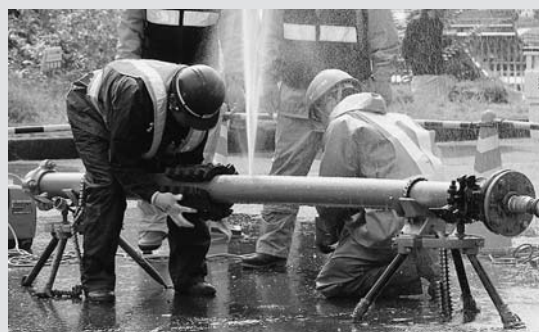
水道管応急復旧訓練
