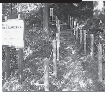
▲八幡町「城山遊歩道改修」
