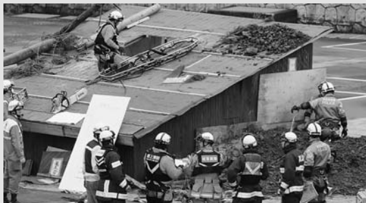
◀土砂災害建物救出訓練
