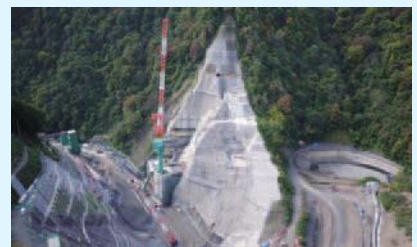
タワークレーン施工状況
