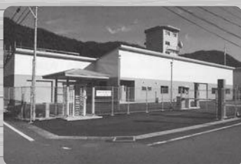
パブリックシステム開発センター [八幡町小野] 施主：パブリックシステム(株) 設計：(株)高垣組建築設計事務所 施工：(株)高垣組
