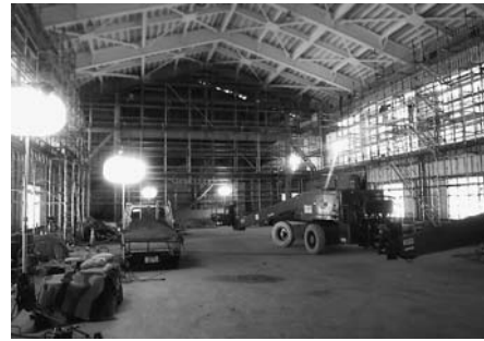
屋内運動場工事の様子
