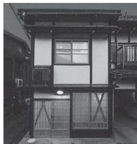
E邸 [八幡町柳町] 施主：塩谷様 設計：(株)スタジオ伝伝 施工：(株)清水建設
