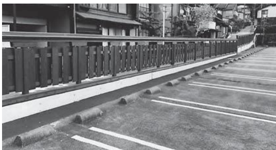
郡上建設業協会駐車場外構 [八幡町殿町] 施主：郡上建設業協会 設計：(株)ヤマシタ工務店一級建築事務所 施工：(株)ヤマシタ工務店
