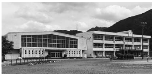
建設予定地としている大和第一北小学校跡地
