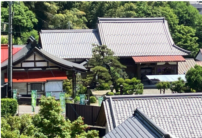
東棟（写真左側）の屋根を鉄板を被せたセメント瓦から瓦に葺替えました。
