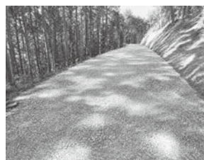
▲新規開設作業道
