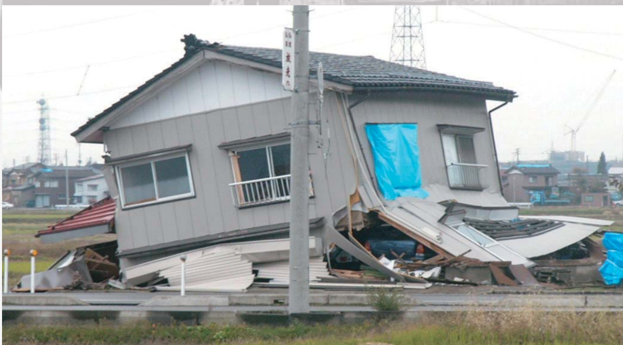
地震による建物の倒壊事例
