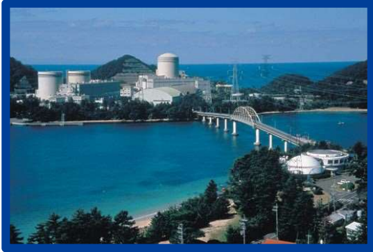
関西電力株式会社 美浜発電所※
