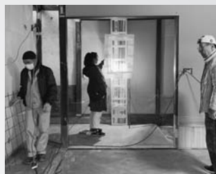
木ノ離の工事の様子 (設計担当の松本智世子と 施工の清水建設)
