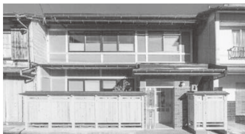
【建築物部門】八幡町島谷（改築）
