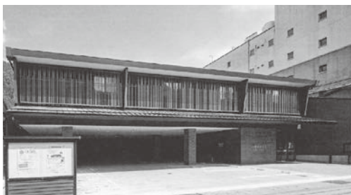
【建築物部門】八幡町新町（新築）
