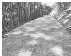
▲新規開設作業道
