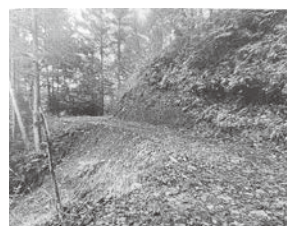
▲既設作業道の補修
