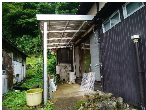
▼玄関脇のテラス屋根部分
