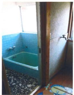
浴室・脱衣所
